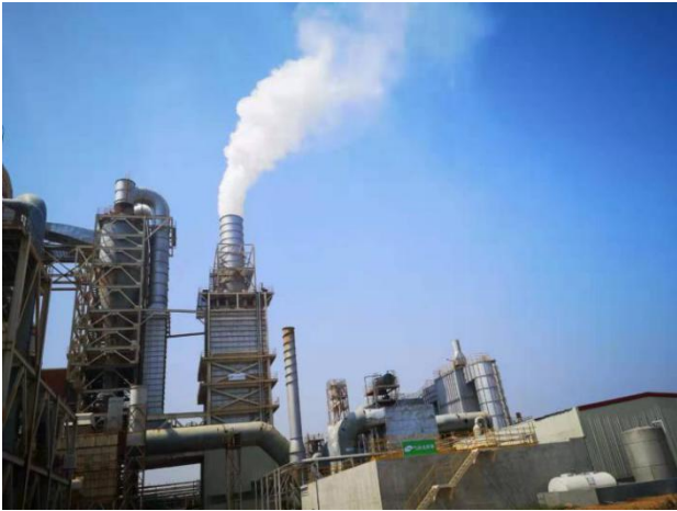
高压开启前效果 Before system start up
